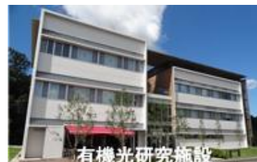
H23年8月竣工、3階建 2,400m 2
