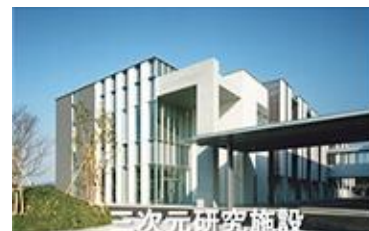
H23年3月竣工、2階建 3,267 m 2
