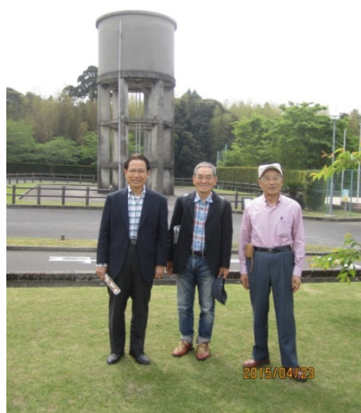
－ 給水塔、ピサの斜塔のように傾いている －
