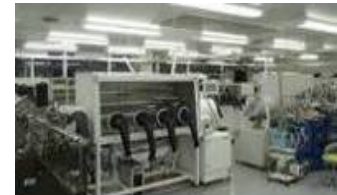
クリーンルーム 104号室
